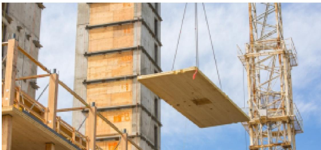
En este estudio, los expertos usaron losas de **madera laminada clavada** (llamamos *NLT* por sus siglas en inglés) y les pusieron una capa de hormigón encima. Para que no se resbalen y trabajen como una sola pieza, las unieron con unos «conectores de corte» (como si fueran unos anclajes súper fuertes).
